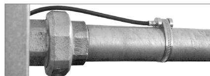
Fig. 22: Povratni temperaturni senzor
