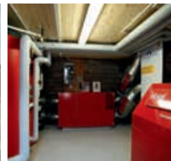
Model ekološkog rešenja u kompleksu sa stambenim i trgovinskim objektima: Grejni sistem obezbeđuje toplotu iz toplotne pumpe podzemna voda/voda, sistem kućne ventilacije sa povratom toplote i vlažnosti vazduha, i fotovoltaični solarni paneli sa Smart-Grid mrežom.
