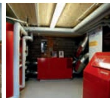
Model ekološkog rešenja u kompleksu sa stambenim i trgovinskim objektima: Grejni sistem obezbeđuje topotu iz topotne pumpe podzemna voda/voda, sistem kućne ventilacije sa povratom topote i vlažnosti vazduha, i fotovoltaični solarni paneli sa Smart-Grid mrežom.
