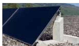
Ugradnja na betonskom postolju
